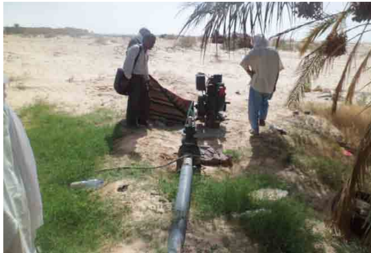
Pompage de l'eau d'irrigation à Noueïl
