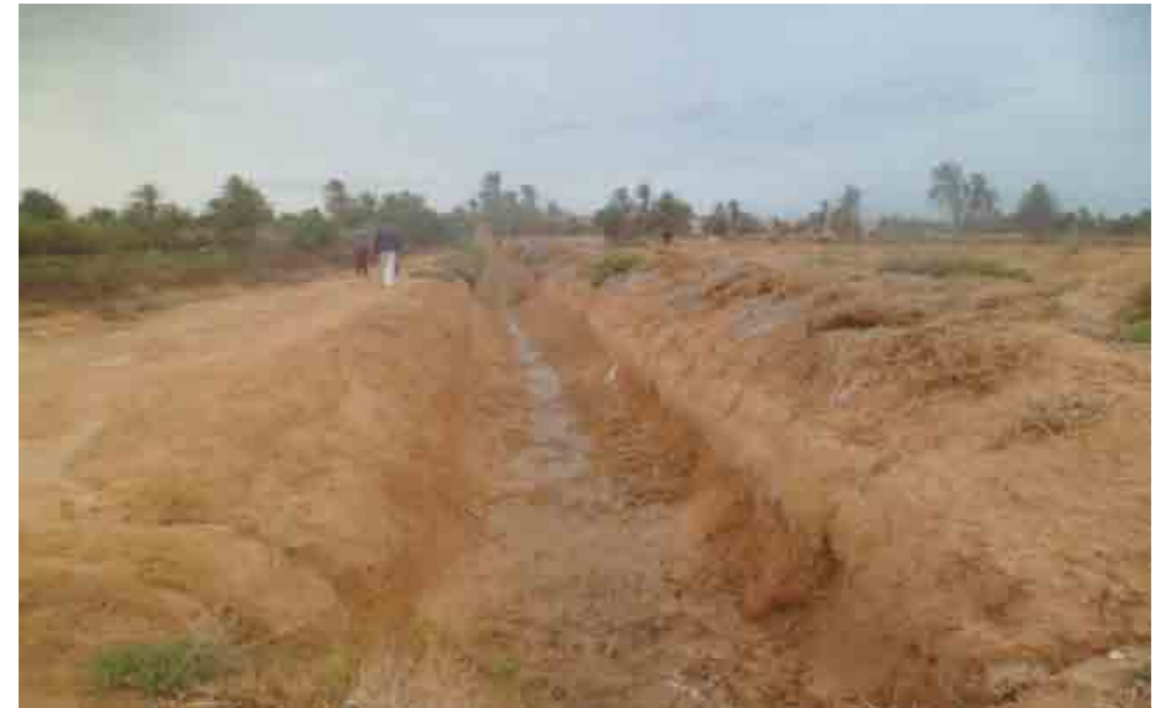
Fossé de drainage hydrique
