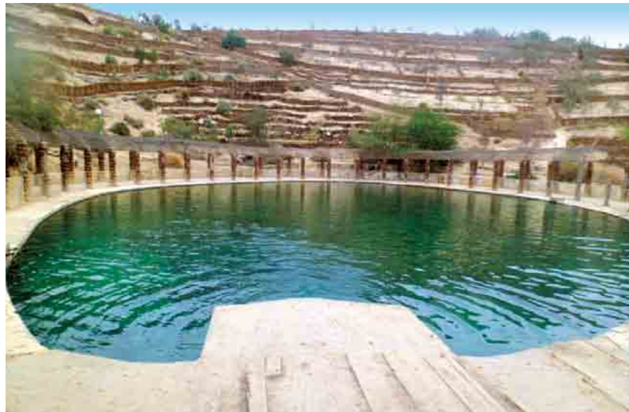
Bassin de stockage d'eau d'irrigation à Nafta
